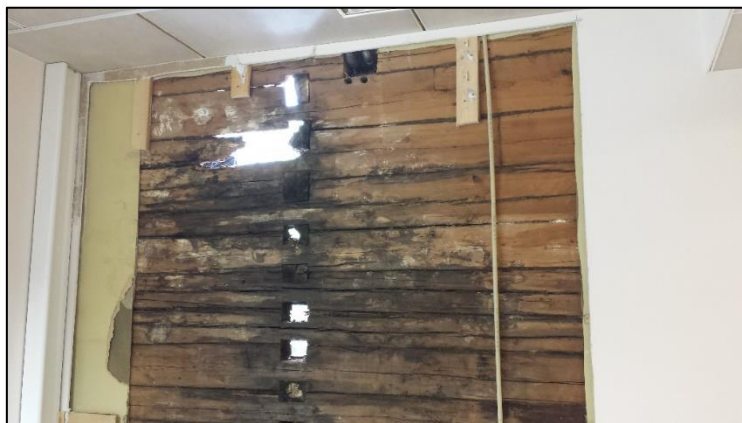
Kuva 2.14. Valokuva hirsirungon vaurioista. Kuvatiedoston päivämäärä 19.7.2013 (lähde: Punkalaitumen kunta).
