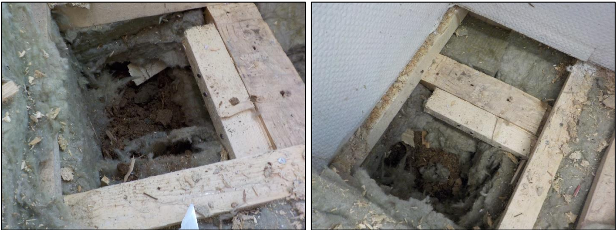
Kuva 2.10. Yleiskuvia rakenneavauksesta AV7.
