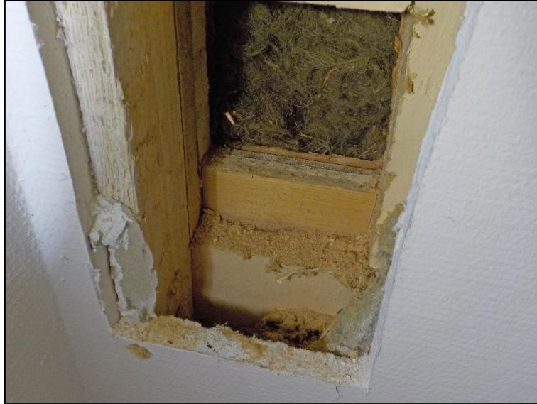
Kuva 2.22. Yleiskuva rakenneavauksesta AV17.
