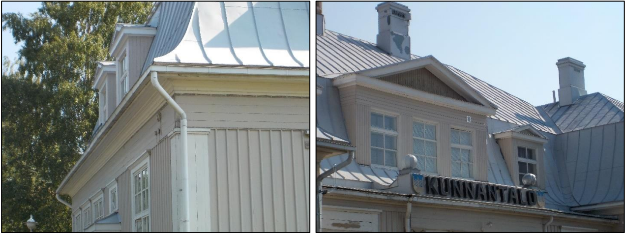
Kuva 2.20. Yleiskuvia ulkoseinärakenteen toteutuksesta.
