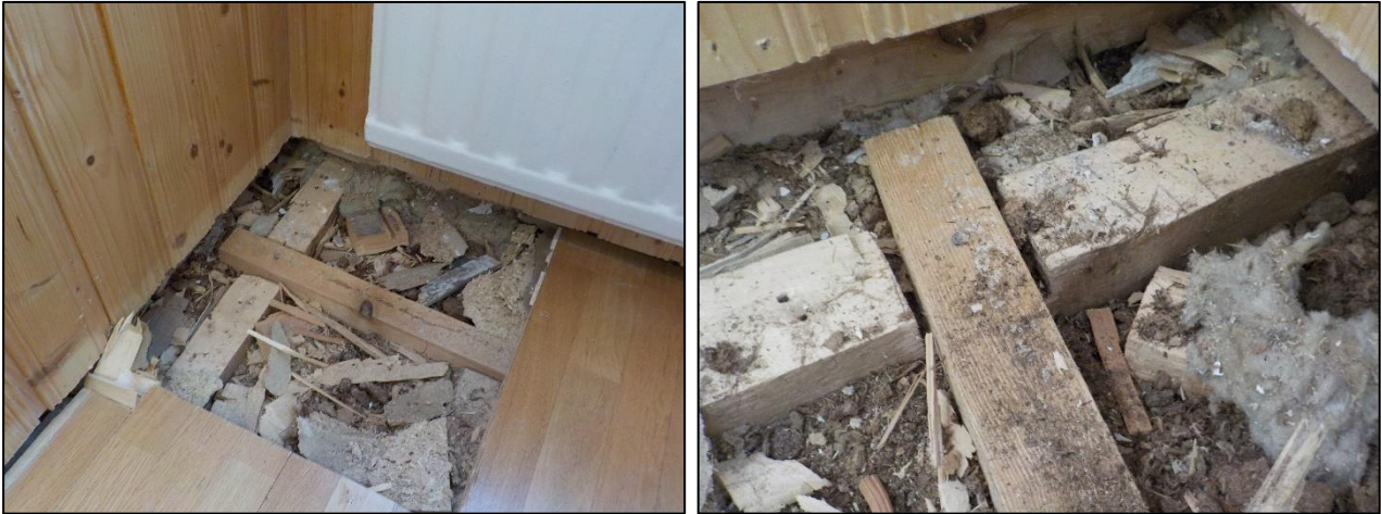
Kuva 2.31. Yleiskuvia rakenneavauksesta AV6.
