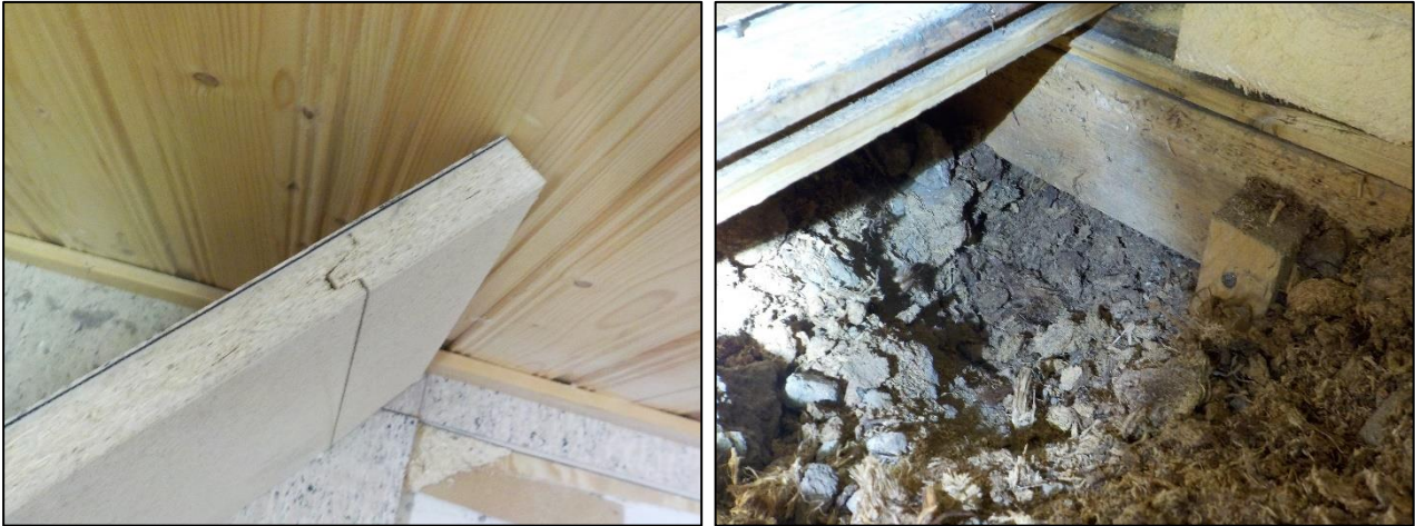
Kuva 2.29. Yleiskuvia rakenneavauksesta AV3.
