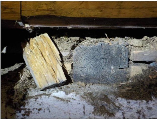
Kuva 2.9. Yleiskuvia kosteuskatkoista puurungon ja betonirakenteiden välillä. Vasemmalla olevasta kuvasta kosteuskatko puuttuu kokonaan ja palkin pää on lahovaurioitunut.
