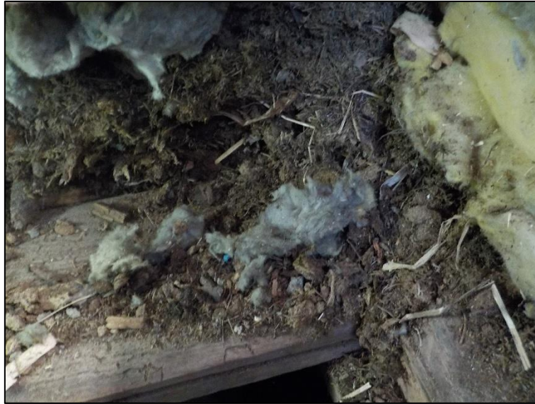
Kuva 2.12. Yleiskuva rakenneavauksesta AV25.
