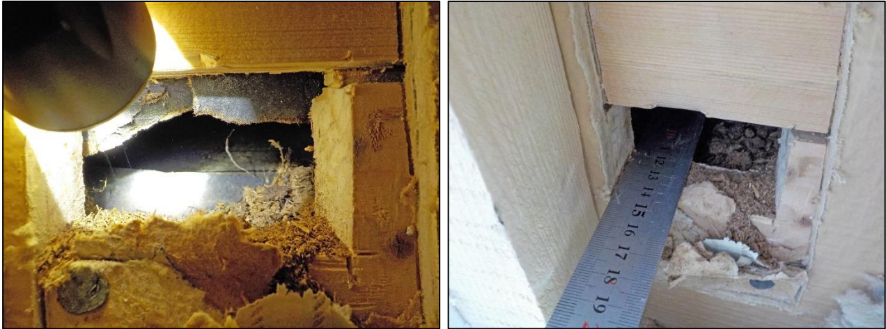
Kuva 2.21. Yleiskuvia rakenneavaukseen AV1 liittyen.
