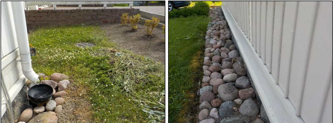
Kuva 2.1. Yleiskuvia kuivatusrakenteiden toteutuksesta.
