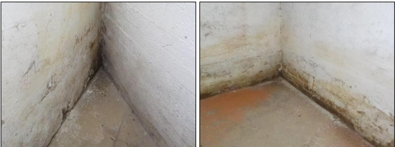
Kuva 2.3. Yleiskuvia käytöstä poistetun kellarin tiloista.
