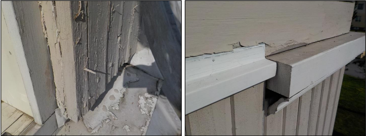
Kuva 2.26. Lähikuvia julkisivusta sekä yhdestä yksityiskohdasta julkisivussa, jonka kosteusteknistä toimivuutta ei ole varmistettu.
