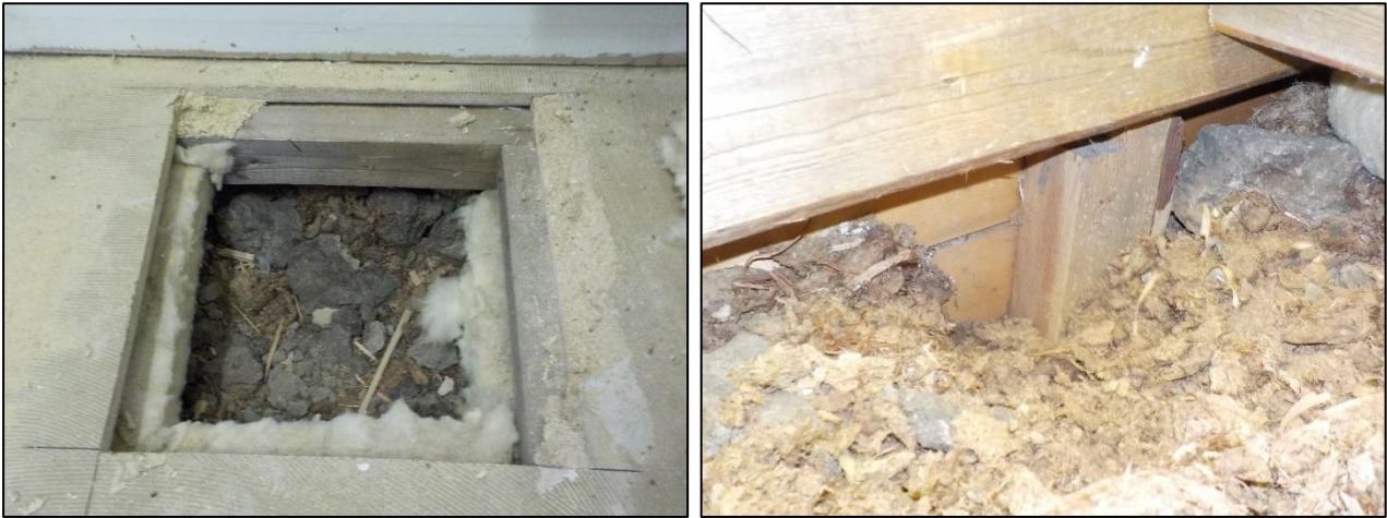
Kuva 2.28. Yleiskuvia rakenneavauksesta AV2.
