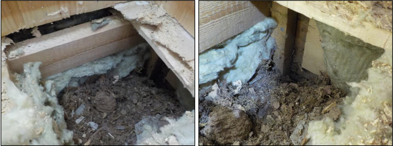
Kuva 2.11. Yleiskuvia rakenneavauksesta AV8.
