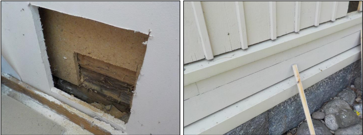
Kuva 2.18. Vasemmalla yleiskuva rakenneavauksesta AV26 ja oikealla yleiskuva ulkoverhouksen alaosan toteutuksesta, joka viittaa alimpien hirsikertojen aiempaan korjaushistoriaan.
