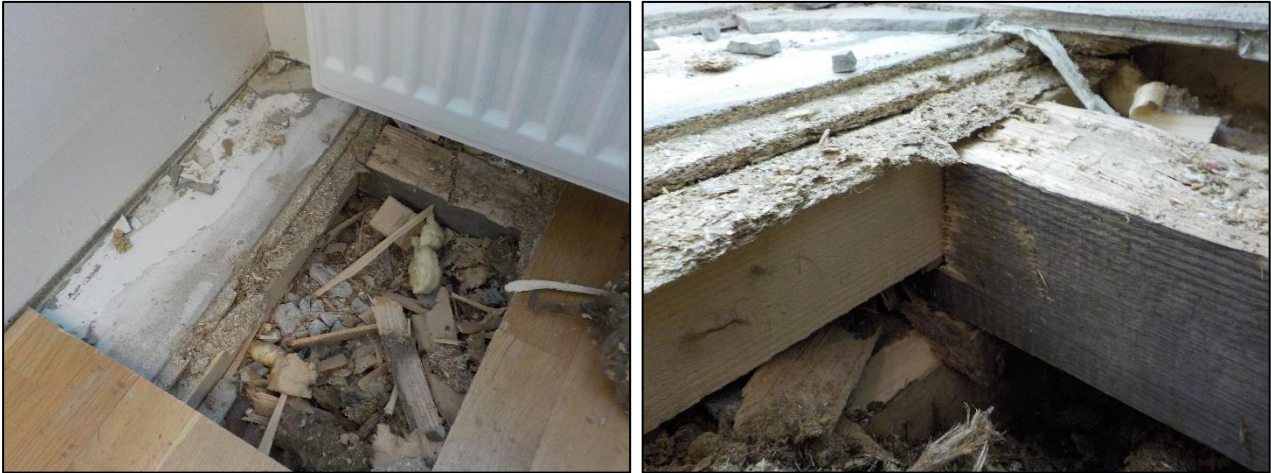
Kuva 2.32. Yleiskuvia rakenneavauksesta AV16.
