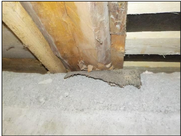
Kuva 2.9. Yleiskuvia kosteuskatkoista puurungon ja betonirakenteiden välillä. Vasemmalla olevasta kuvasta kosteuskatko puuttuu kokonaan ja palkin pää on lahovaurioitunut.
