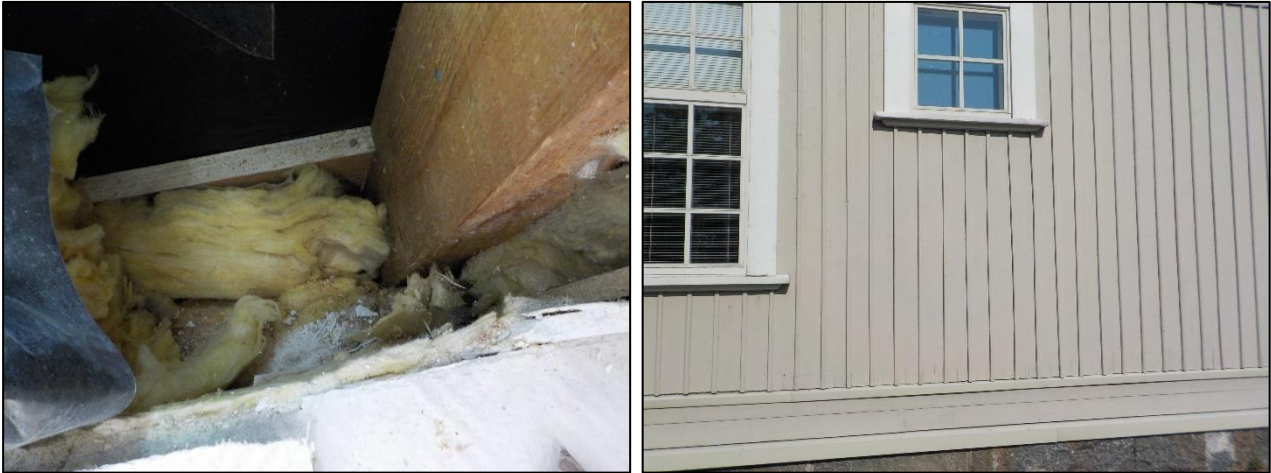
Kuva 2.23. Vasemmalla on yleiskuva rakenneavauksesta ja oikealla yleiskuva julkisivusta. Rakenneavaus sijoittuu kuvassa näkyvän pienen ikkunan alapuolelle.
