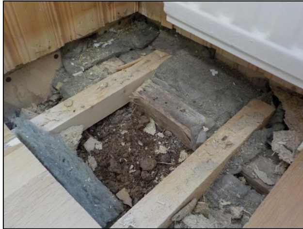
Kuva 2.30. Yleiskuva rakenneavauksesta AV4.
