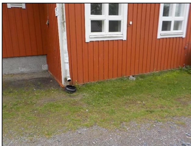
Kuva 2.1. Sokkelikorkeus on paikoin hyvin matala.
