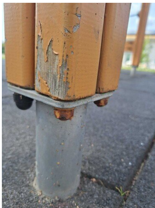
Kuva 28 Mutterinsuojat puuttuu
