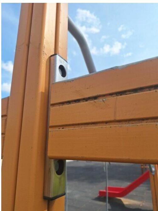
Kuva 27 Mutterinsuoja puuttuu
