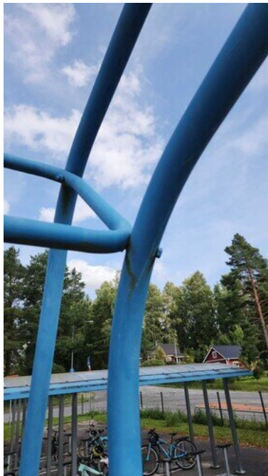
Kuva 41 Ruuvit löysällä
