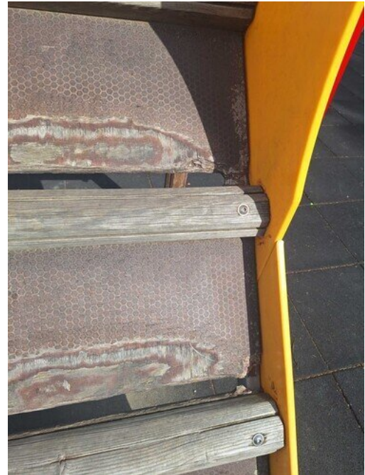
Kuva 23 Vaneri, kulunut, laho, puuttuu kappaleita, irti rungosta
