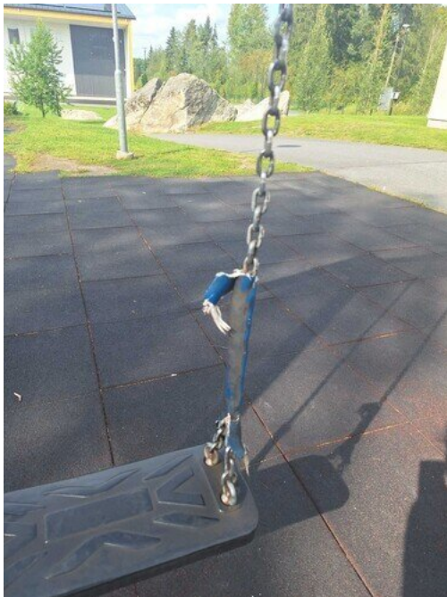
Kuva 13 Ketjun suojat rikki
