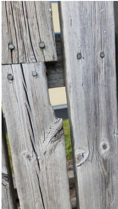
Kuva 37 Pala puuttuu
