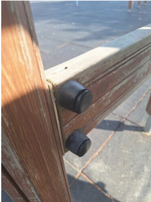
Kuva 22 Ruuvit löysällä
