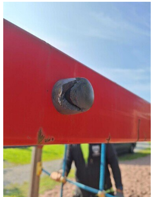
Kuva 4 Mutterinsuoja rikki
