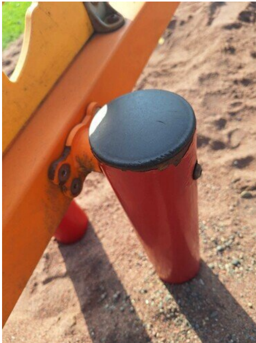
Kuva 30 Metalliosat ruosteessa
