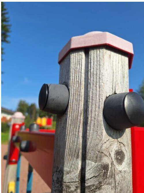
Kuva 6 Ruuvit löysällä
