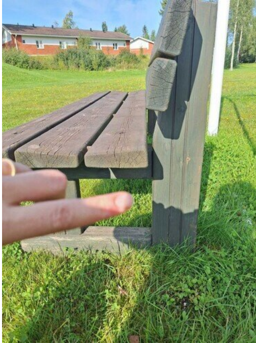
Kuva 47 Ruuvit löysällä
