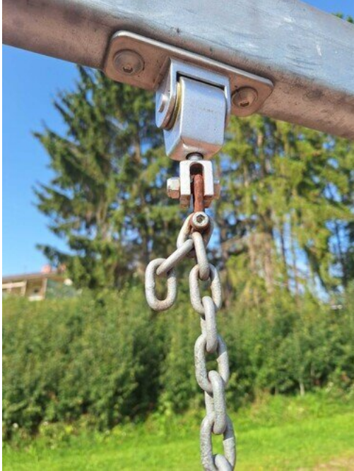
Kuva 48 Ketjut lyhennetty
