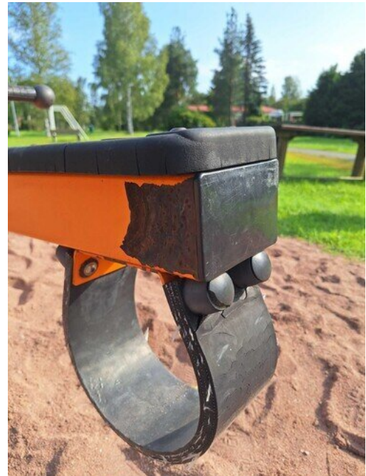
Kuva 31 Metalliosat ruosteessa
