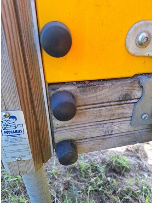
Kuva 39 Ruuvit löysällä
