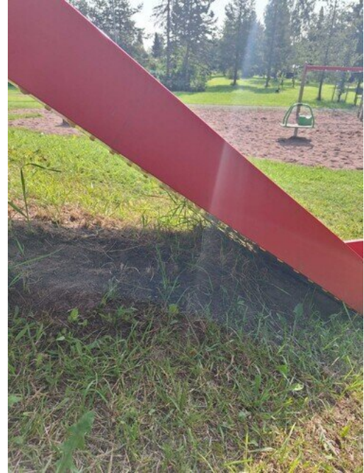
Kuva 42 Rako, hupparinnarun kiinnijuuttumisriski
