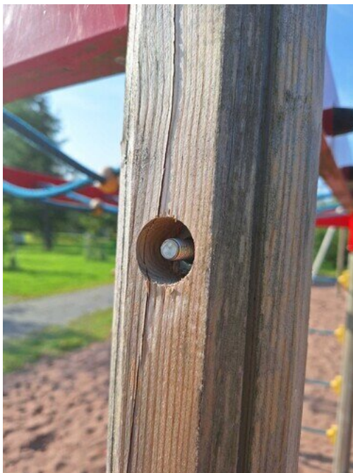
Kuva 3 Mutterinsuoja puuttuu
