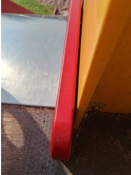
Kuva 42 Rako, hupparinnarun kiinnijuuttumisriski
