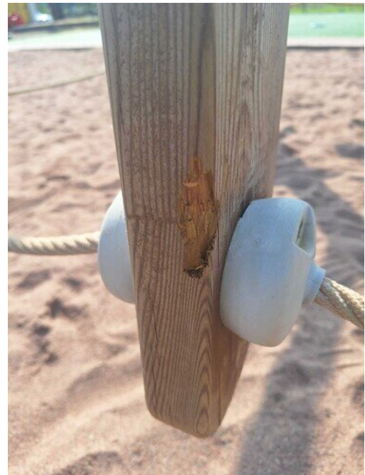
Kuva 41 Tikkuja, pala puuttuu
