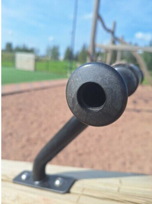
Kuva 48 Käsikahvan tulppa puuttuu
