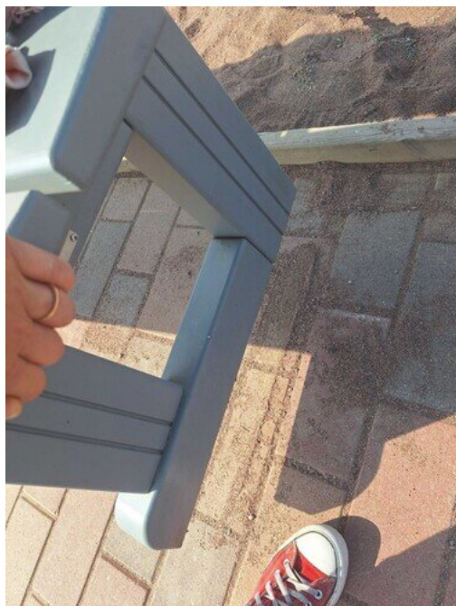
Kuva 51 Irtonainen, leikkipaikalla tai sen välittömässä läheisyydessä sijaitsevien kalusteiden tulisi olla kiinnitettyjä, jotta niitä ei siirreltäisi esimerkiksi leikkivälineiden turva-alueille tai paikkoihin, joka mahdollistaisi ei-toivotun kiipeilyn
