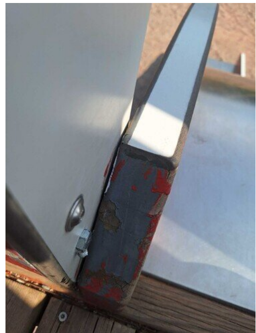
Kuva 15 Hupparinnarun kiinnijuuttumisvaara
