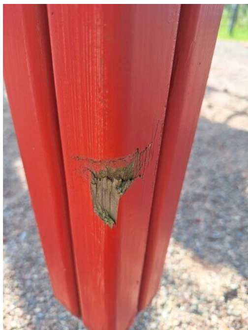
Kuva 8 Puuosat rikki, tikkuja
