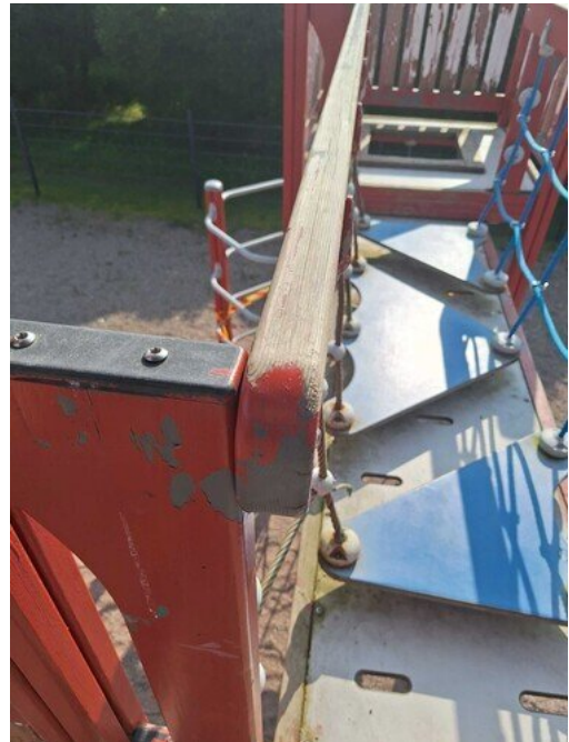
Kuva 12 Ruuvit löysällä
