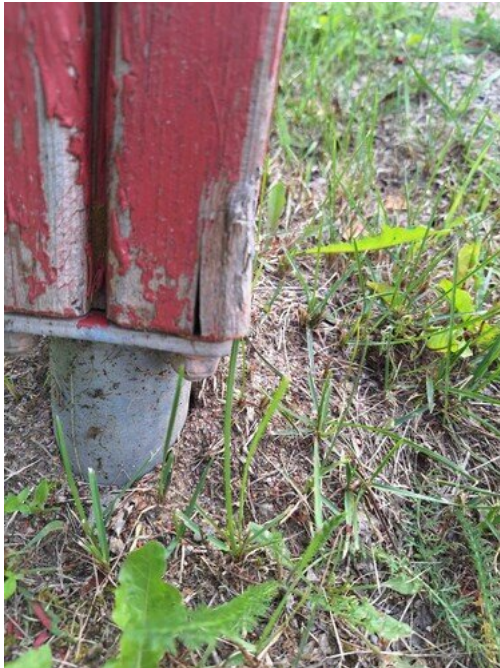
Kuva 49 Mutterinsuojat puuttuu
