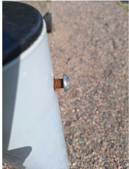
Kuva 55 Kiinnitys irti
