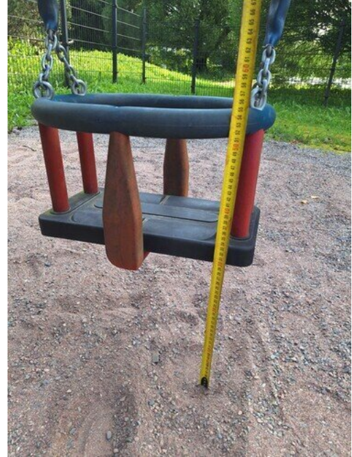
Kuva 52 Istuimet liian matalalla
