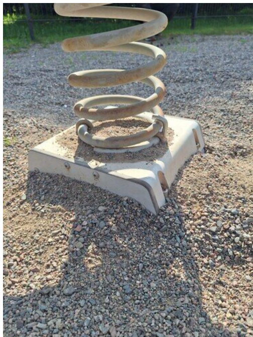
Kuva 67 Perustus maan pinnassa
