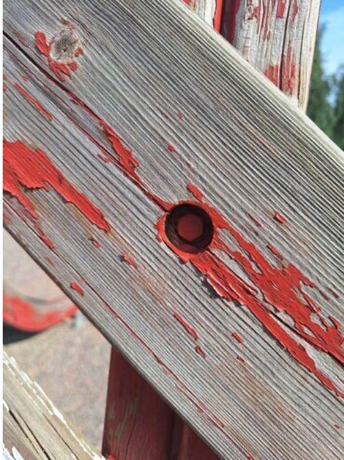
Kuva 41 Mutterinsuojat puuttuu
