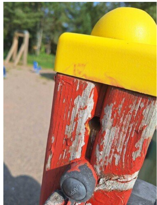
Kuva 44 Sormen kiinnijuuttumisvaara
