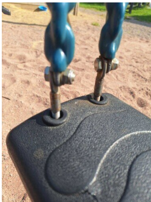
Kuva 62 Kiinnitys puutteellinen
