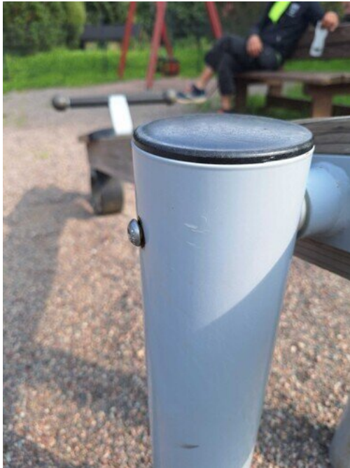
Kuva 54 Kiinnitys löysä
