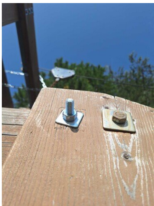
Kuva 17 Mutterinsuojat puuttuu
