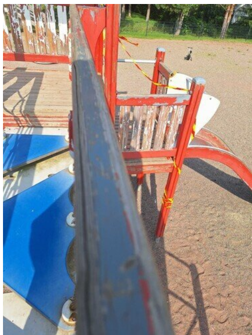
Kuva 7 Puuosat kuluneet
