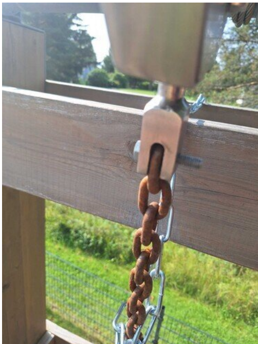
Kuva 25 Mutteri puuttuu
