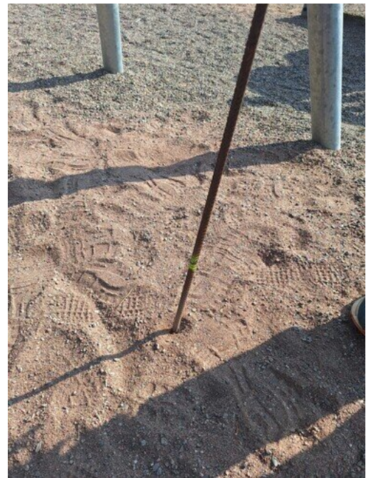
Kuva 32 Puutteellinen turva-alusta
