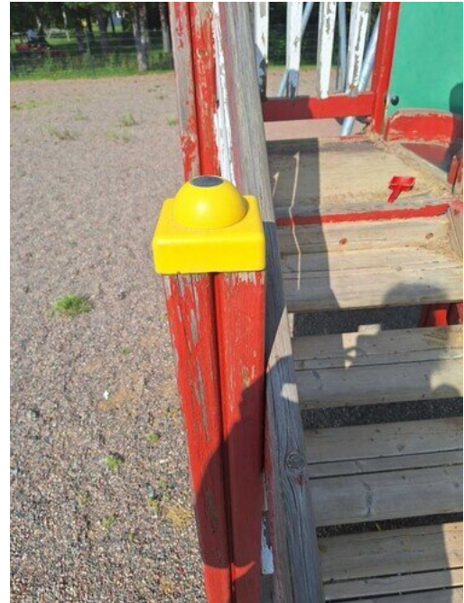
Kuva 40 Tolpan sääsuojat löysät
