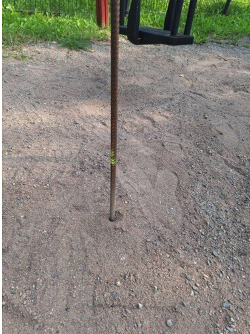
Kuva 51 Puutteellinen turva-alusta
