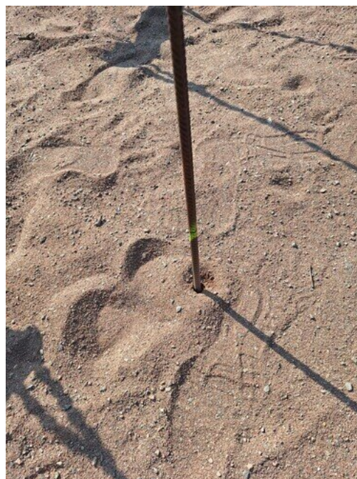
Kuva 63 Puutteellinen turva-alusta
