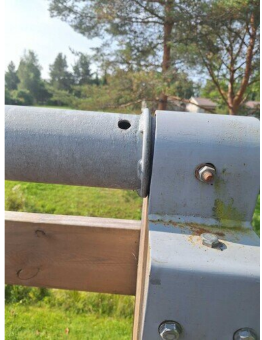
Kuva 24 Sormen kiinnijuuttumisriski
