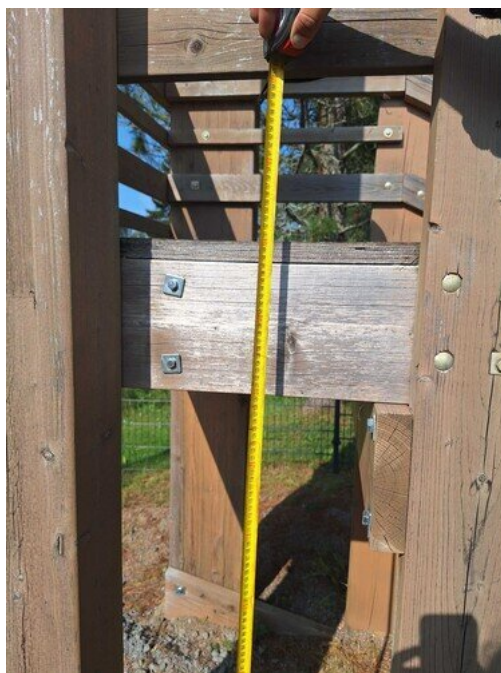
Kuva 22 Tasosta katsottuna putoamiskorkeus 1,50 m
