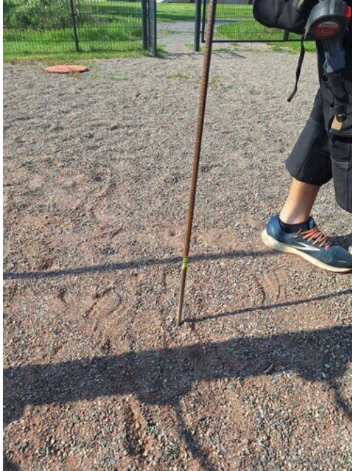
Kuva 16 Turva-alusta puutteellinen
