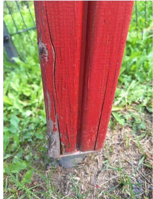
Kuva 50 Puuosat kuluneet
