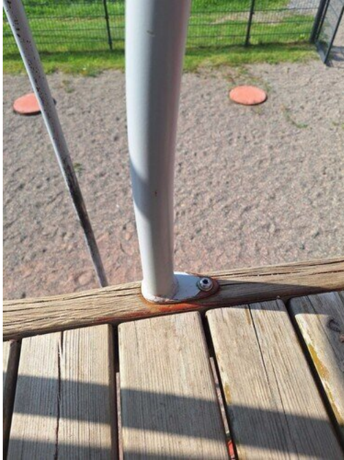
Kuva 13 Suojakaiteet löysällä
