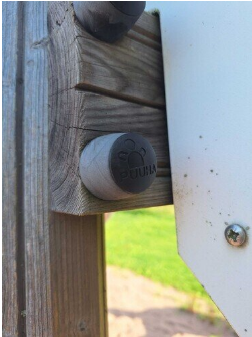
Kuva 74 Ruuvit löysällä
