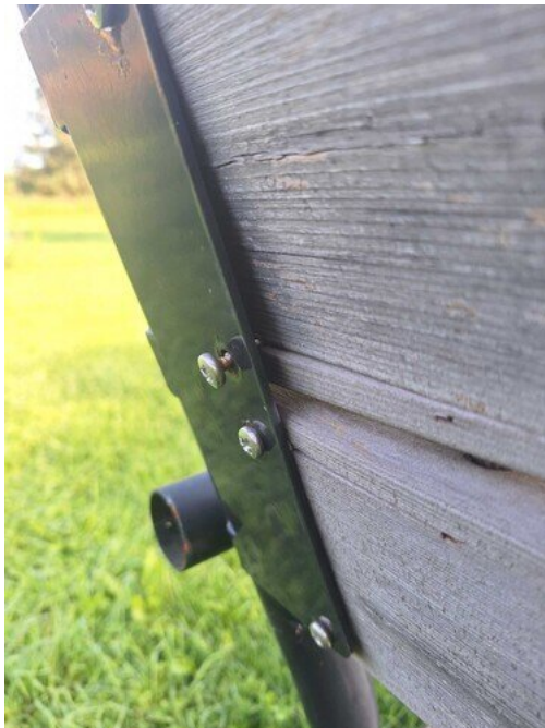
Kuva 21 Ruuvit löysällä
