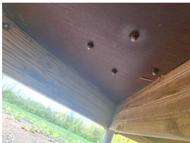
Kuva 24 Mutterisuojat puuttuu
