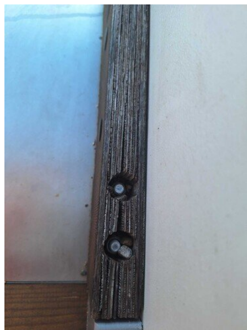
Kuva 13 Mutterinsuojat puuttuu
