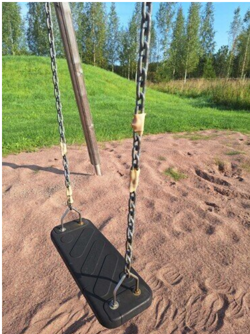
Kuva 54 Ketjunsuojat rikki
