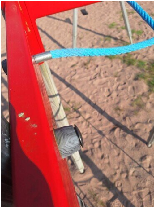
Kuva 63 Ruuvit löysällä
