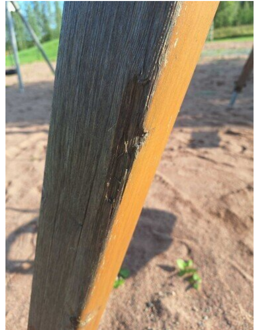
Kuva 30 Pala irti, tikkuja
