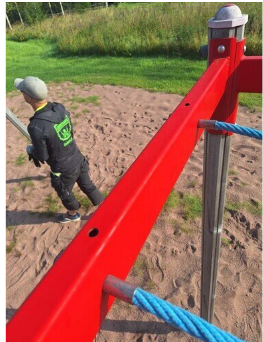
Kuva 60 Sormen kiinni juuttumisriski
