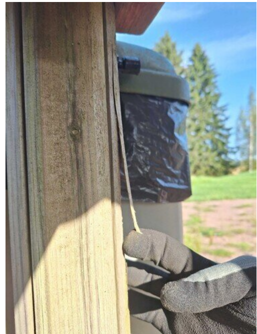
Kuva 45 Puuosat rikki/tikkuja
