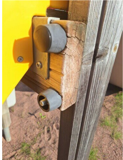
Kuva 47 Mutterit löysällä
