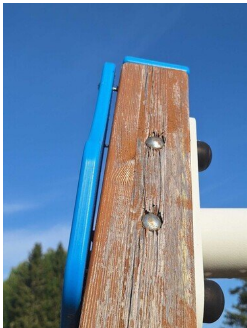
Kuva 31 Ruuvit löysällä
