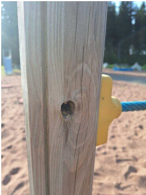
Kuva 59 Sormen kiinni juuttumisriski
