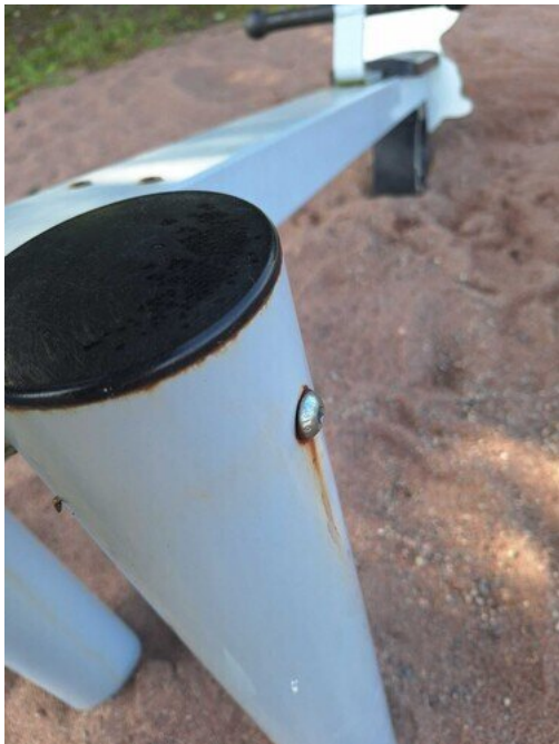
Kuva 80 Ruuvit löysällä
