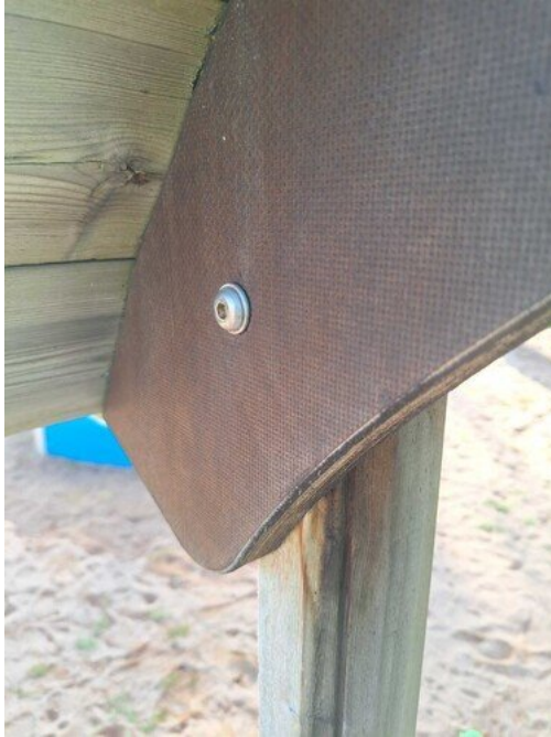
Kuva 25 Kattoruuvit löysällä
